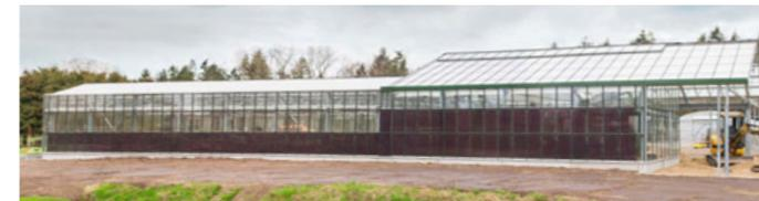
Die Dünnschichtsolarmodultechnik des Gewächshauses erzeugt regenerativ einen Teil der in der Gärtnerei benötigten
