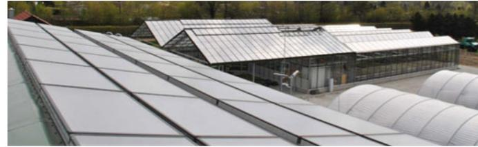
Solarthermie dient der Heizungsunterstützung und der Warmwasserbereitung. Die Installation der Sonnenkollektoren erfolgte auf der sonnenzugewandten Dachseite des Verwaltungsgebäudes.
