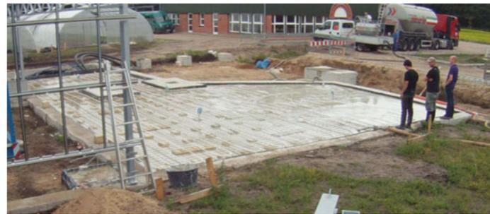
Bei regenerativer Erzeugung fallen Energiebereitstellung und -bedarf häufig zeitlich auseinander, was zu kurzfristigen aber auch saisonalen Schwankungen führt. Sonne ist oft da, wenn kein Heizbedarf besteht und umgekehrt. Mit der Einbringung eines innovativen, wasseraufnehmenden thermischen Füllbaustoffs unterhalb des Arbeits- und Verkaufsräumens, der hohe Wärmespeicherfähigkeiten aufweist, werden tageszeitliche Schwankungen an regenerativer Solarenergie mit dem
