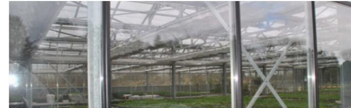
Bei dem Gewächshaus des Lebenshilfwerkes wurde – anders als bei herkömmlichen Gewächshausbauten – ein besonderer Schwerpunkt auf die Wärmedämmung gelegt. Das gesamte verbaute Isolierglas zeichnet sich durch einen sehr geringen Wärmedurchgangskoeffizienten aus, der den für Niedrigenergiehaus-Fenster nach der aktuellen EnEV sogar unterschreitet.
